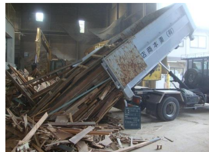
⑤処分場到着、廃棄物を荷下ろし
